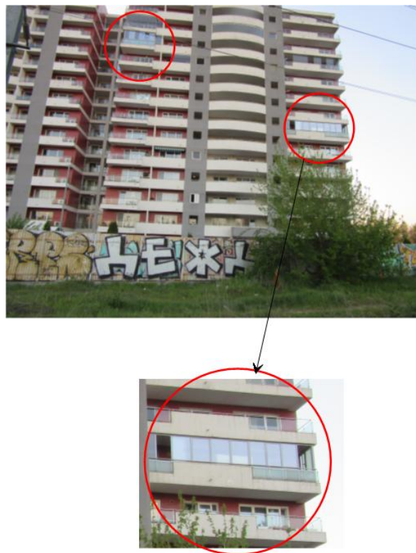
Fig. 7: Fatadele blocurilor din ansamblul rezidential. Prin initiativele unor locatari, cateva locuinte au fost reabilitate termic, cu consecinte favorabile si asupra ambiantei acustice din interior.
